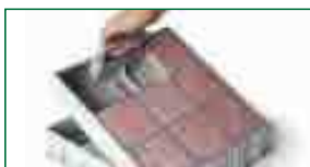
Facile installazione in cantiere
